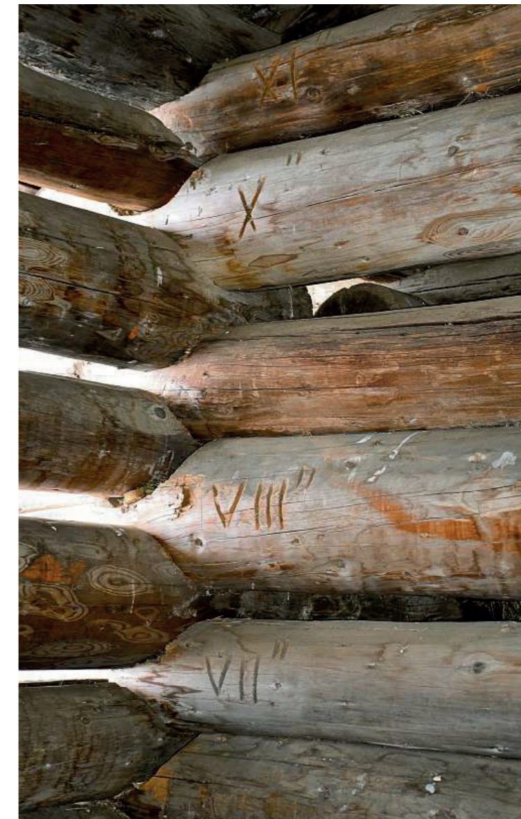
Die eingeritzten Zahlen erleichtern den Wiederaufbau des Stalls an einem anderen Ort. Bild Uwe Oster
